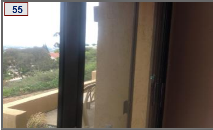
Bedroom 2 Sliding Door Hits Door When Closing
